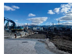
輪島市での公費解体
