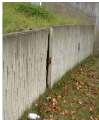
高低差の大きい土地における擁壁等のひび割れやズレ
