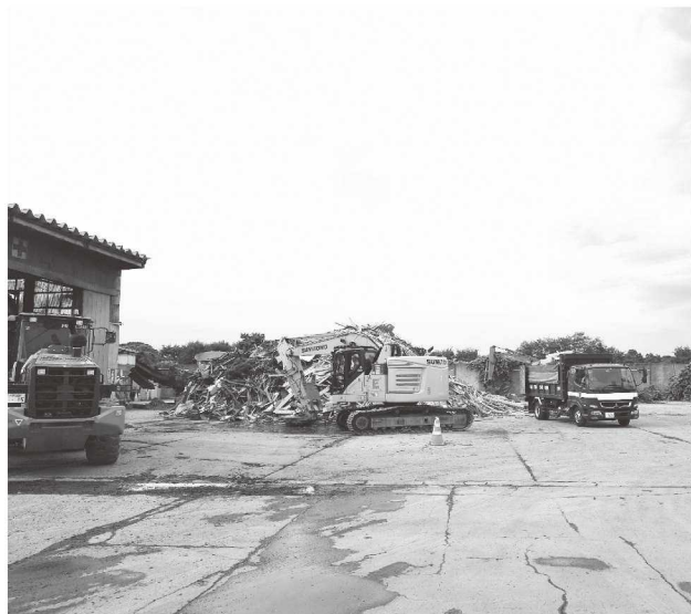
材木のリサイクルプラント
