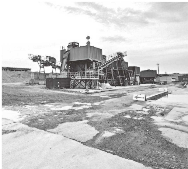
コンクリートのリサイクルプラント
